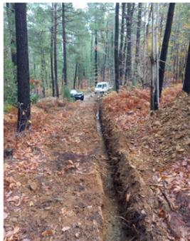
Ce chantier conduit par la REAAL en trois phases a débuté l'année dernière par le remplacement de l'intégralité des 2300 mètres linéaires (ml) de conduite (Ø 90 mm) entre les deux réservoirs de Chalap et des Fourches.
